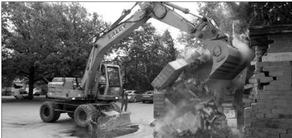
Uue ravikorpuse ehituse eeltööd alustati vana garaažihoone lammutamisega.
