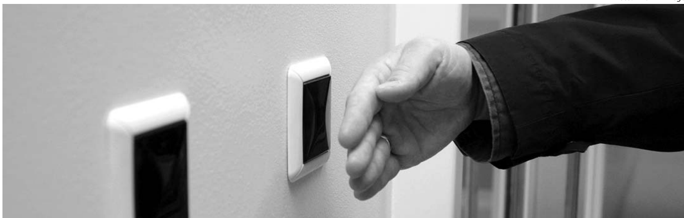
Uues korpuses pole uste avamiseks tarvis neid käega puudutada, mis on haigla nakkustõrje aspektist äärmiselt oluline uuendus. Automaatikaga puutevabade uste infrapuna andurid reageerivad käesoojusele.
