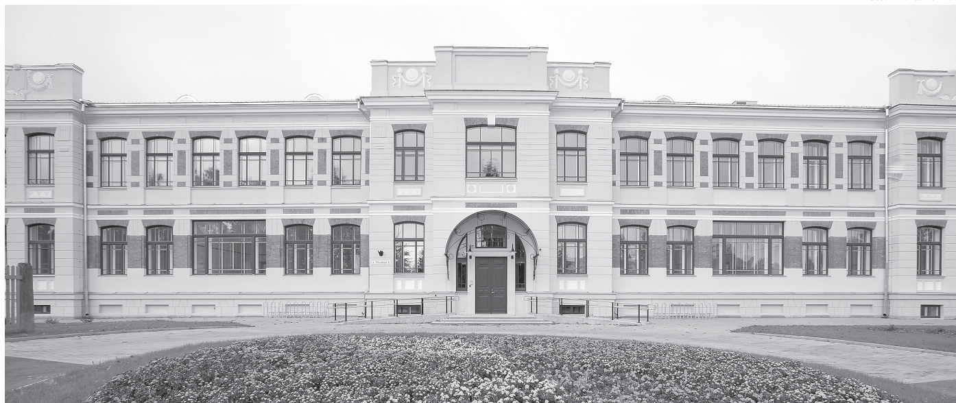
Renoveeritud L. Puusepa 6 hoone
